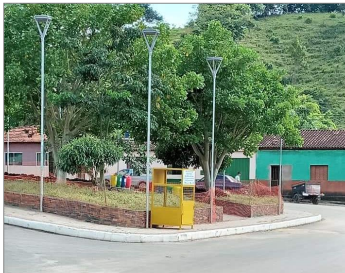
Figura 56 - Instalação dos PEVs
