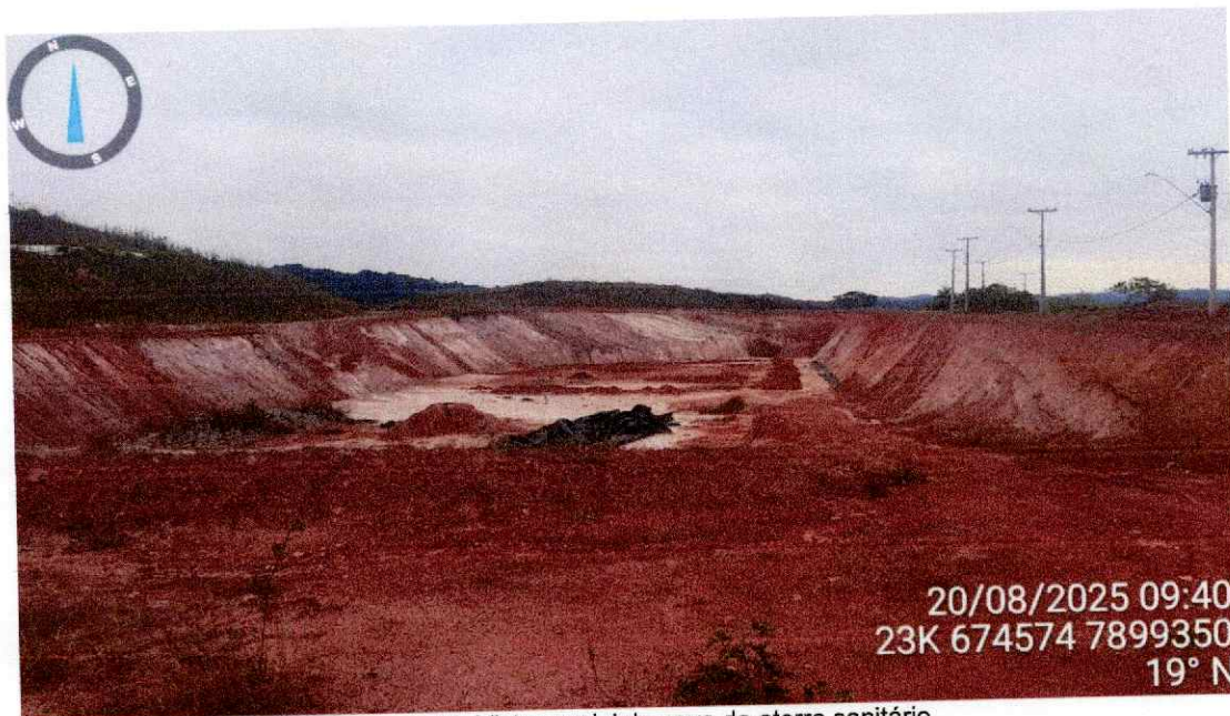
Imagem 01: Vista parcial da cava do aterro sanitário
