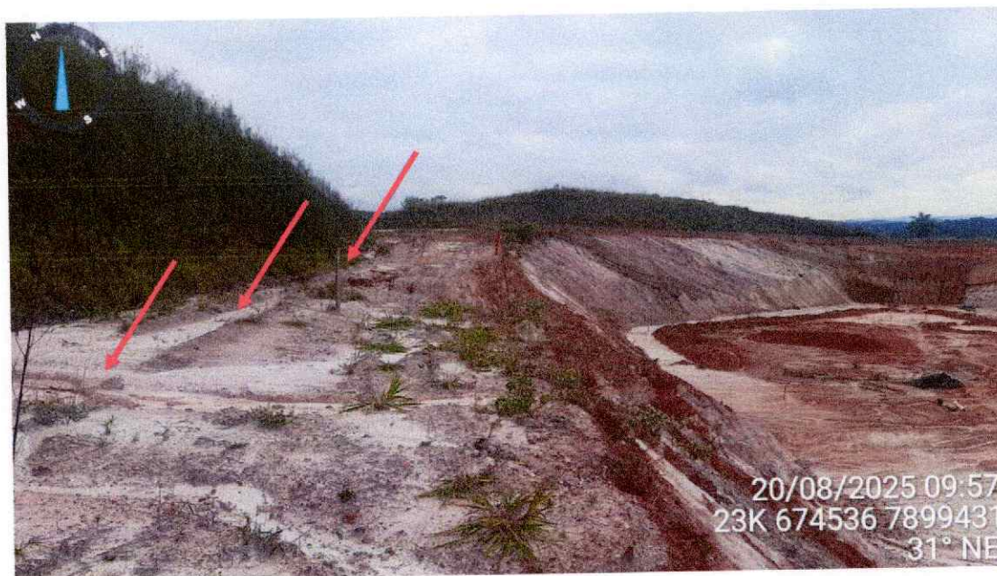
Imagem 04: Vista parcial da berma sobreposta ao primeiro talude da face NW da cava (no detalhe a drenagem obstruída no pé do talude adjacente)
